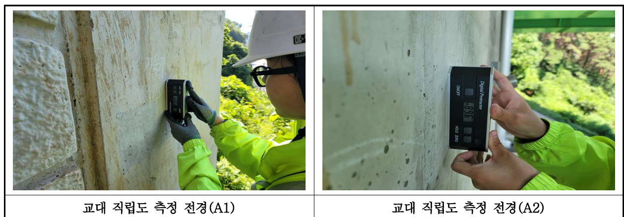
【사진 19.3.11】 교대 직립도 측정 작업사진 전경
