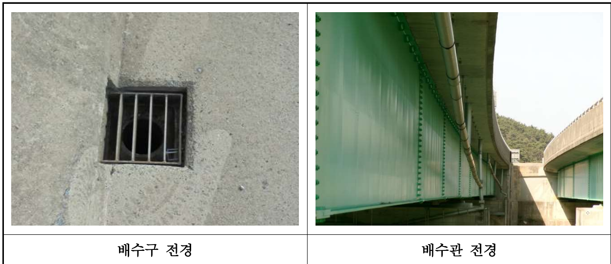
【사진 19.3.24】 배수시설 전경
