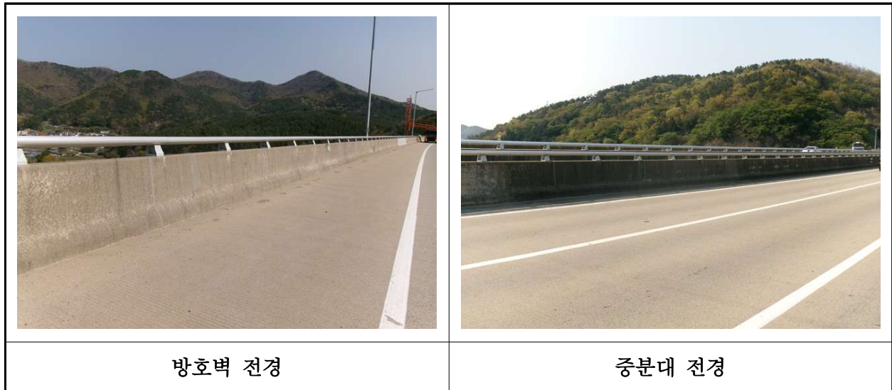
【사진 19.3.26】 방호벽 및 중분대 전경
