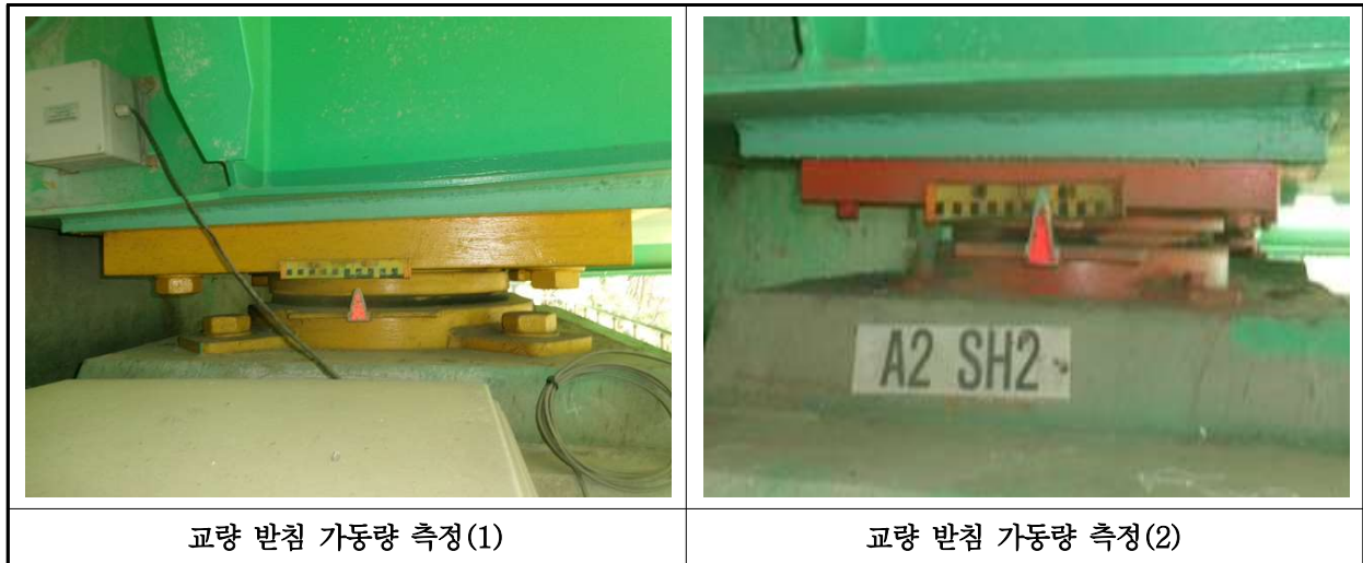
【사진 19.3.18】 교량받침 이동량 측정
