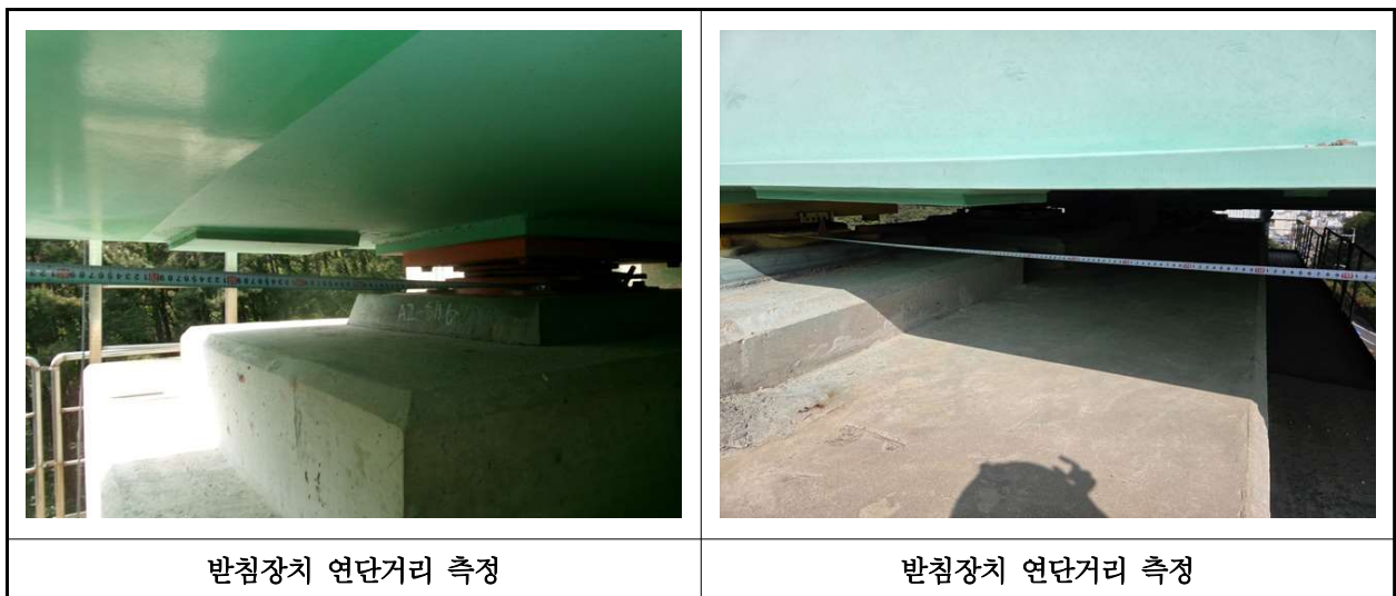
【사진 19.3.17】 교량받침장치 연단거리측정
