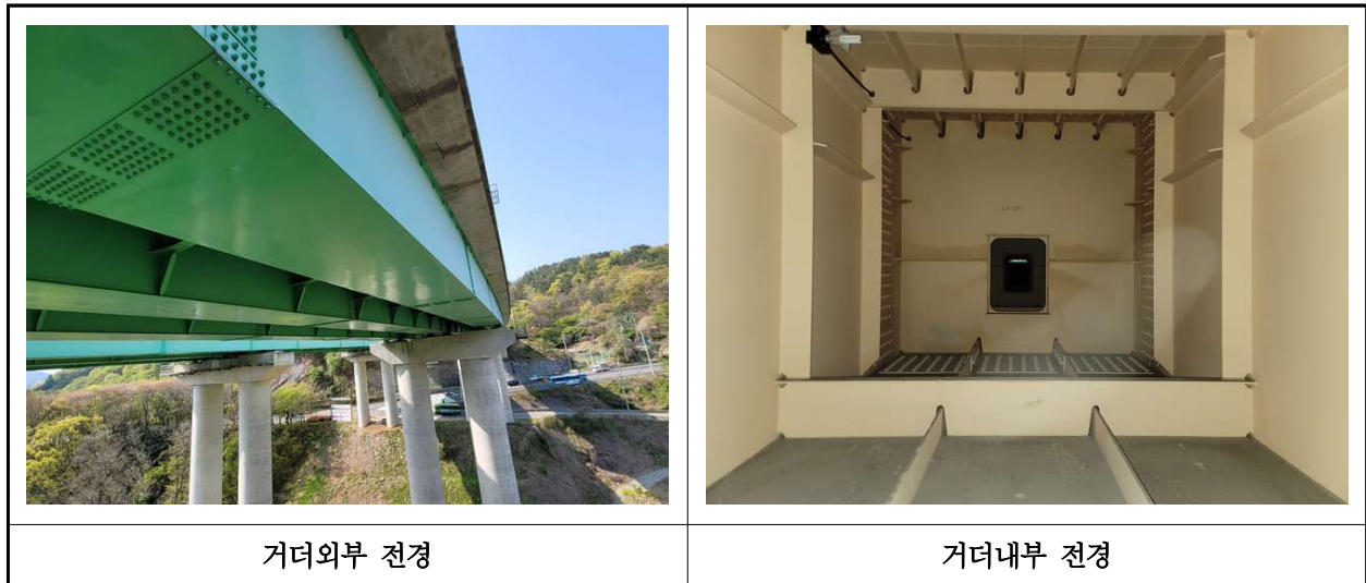
【사진 19.3.4】 거더 전경
