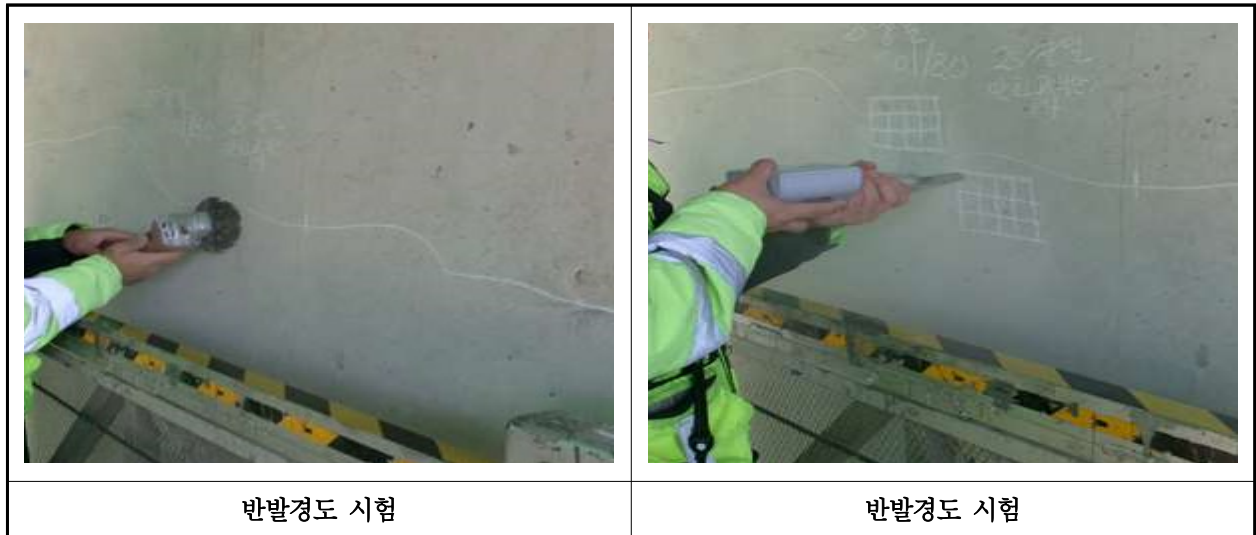
【사진 19.4.2】 반발경도시험 현장사진
