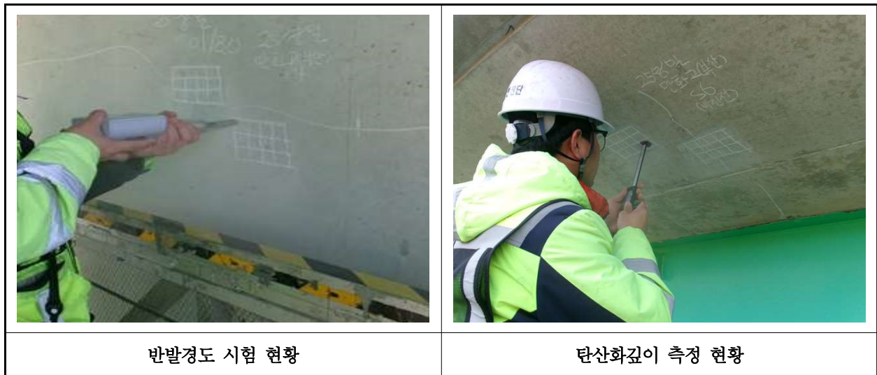
【사진 19.4.1】 콘크리트 내구성조사 현황
