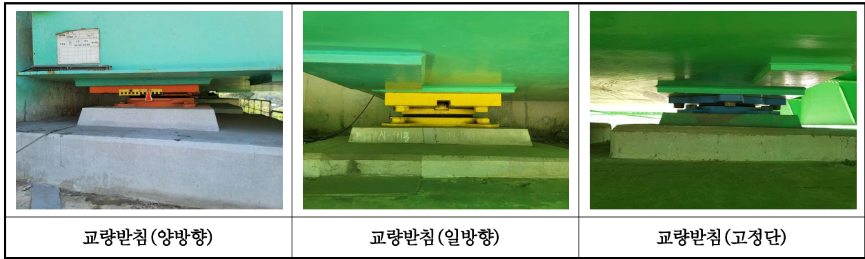
【사진 19.3.15】 교량받침 전경
