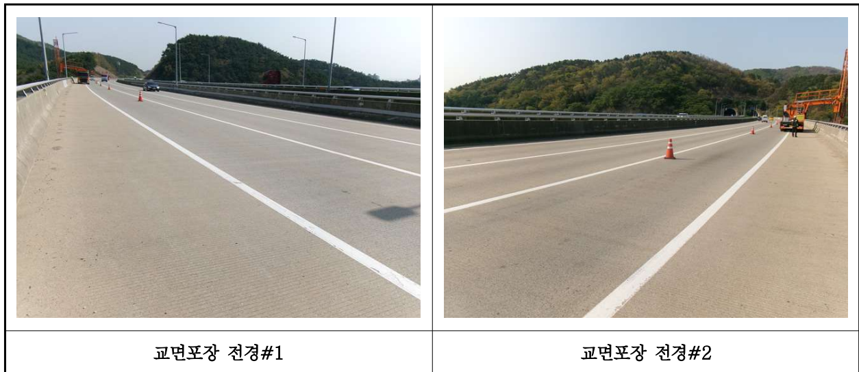
【사진 19.3.22】 교면포장 전경
