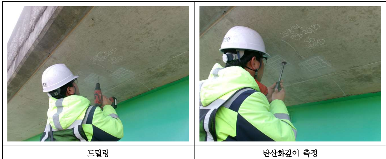
【사진 19.4.3】 탄산화 깊이 측정 현장사진
